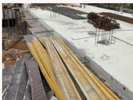
Préparation de la dalle
