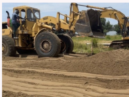
Équipements et matériaux sur site
