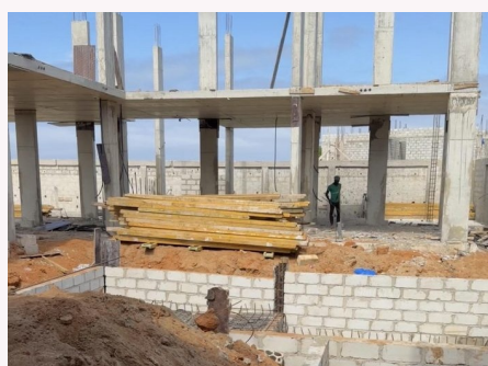
Structure en construction
